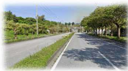
沖縄自動車道～中城湾港等の産業拠点を結ぶ県道85号線（沖縄環状線東）
