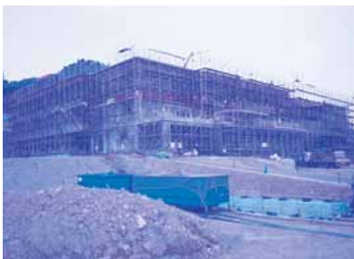
▲供用開始に向け工事も急ピッチ！中原小学校
