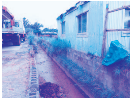
農道1057号沿い排水路
