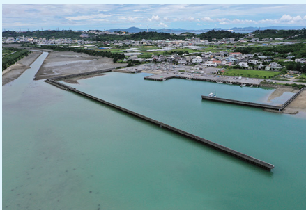
機能保全等が行われる 南原漁港の第一防波堤
