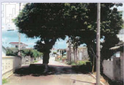
辺地債を活用し、生活基盤を整備することで、生活環境の向上と生産基盤の安定化を図っている (写真：伊計集落内)
