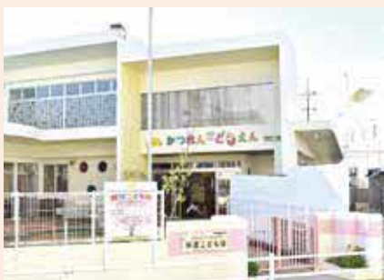
改修工事が進む勝連こども園
