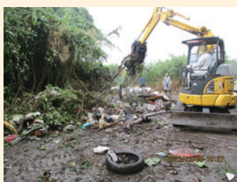
重機で処理される不法投棄ゴミ
