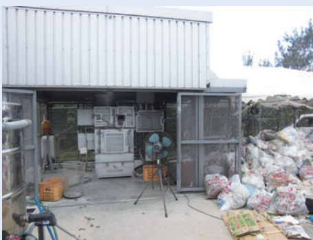
津堅島のごみを処理する小型焼却炉
