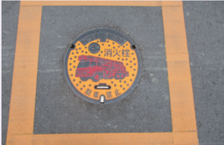
塩屋地内に設置された地下式消火栓上に物を置かないようにしましょう
