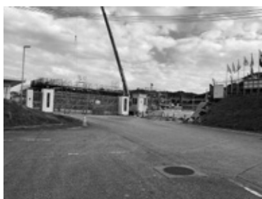
工事が進む勝連分屯地
