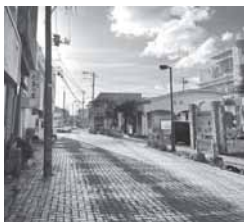
舗装工事が予定される市道石川2号線
