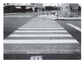
カラー舗装化されたあげな小近くの横断歩道
