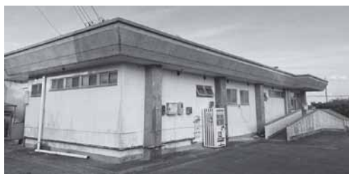
日頃から愛用されている石川プール。老朽化が進んでいることから、建て替えを要望しました。
