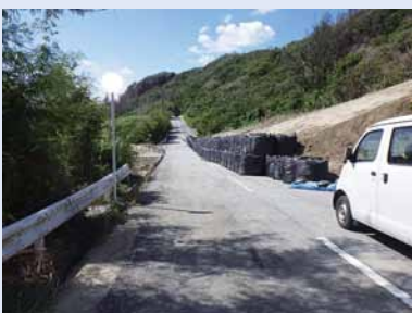
台風第6号で土砂災害のあった一般農道宮城線の復旧工事が行われる。
