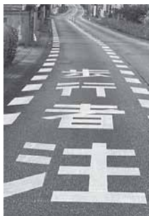
スピード抑制のため、工事が実施された西原公民館前の県道
