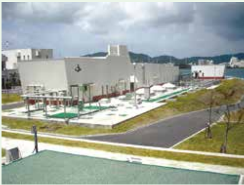
石川終末処理場(C系列水処理設備)
