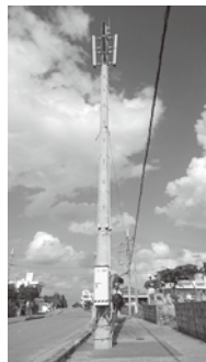
システムの統合、老朽化対策及びデジタル化を推進するため、新たなシステムを整備した。
