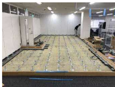
OAフロア施工時の様子
