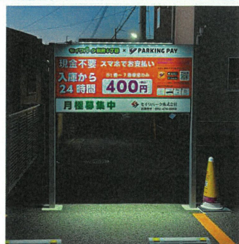
【参考事例】看板GL高さ:2400mm / 看板面サイズ:H910×W1830mm / 600Lを2台連結
