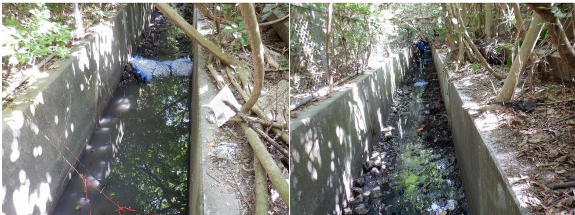
図- 2.1-34 牡蠣殻接触浄化剤の設置状況
