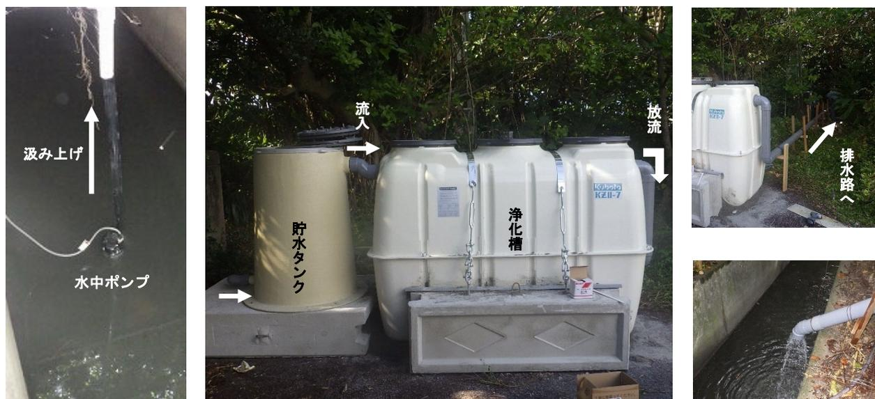
図- 2.1-30 小型浄化槽の設置状況
