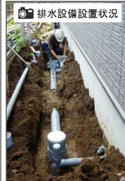
図- 2.1-19 下水道の接続補助の例
