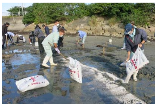
底質改良剤散布の様子
