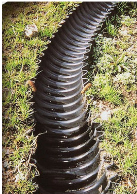
芝に埋め込まれた半円形のコルゲート管
