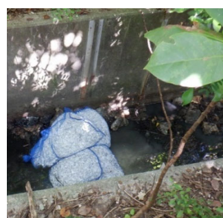
接触浄化による水質浄化 (有機物除去) (牡蠣殻接触浄化の様子)
