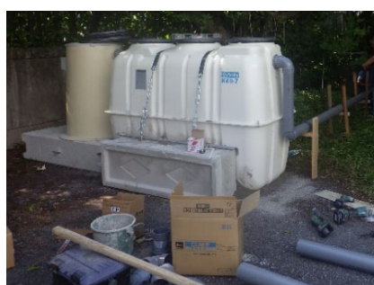
小型浄化槽による水質浄化 (有機物除去) (海中道路周辺海域自然環境再生事業 実証試験時)
