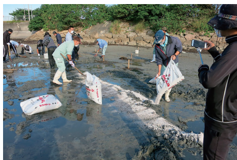
浄化材（干潟改良剤）散布
