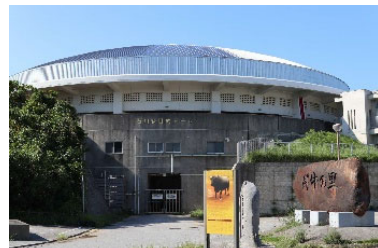
石川多目的ドーム
