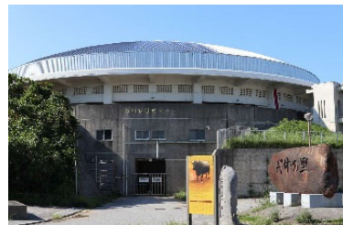
石川多目的ドーム
