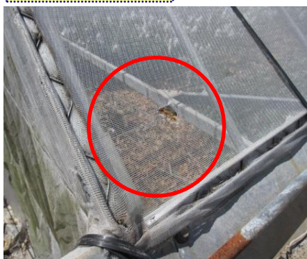
ネット等の破れの補修
