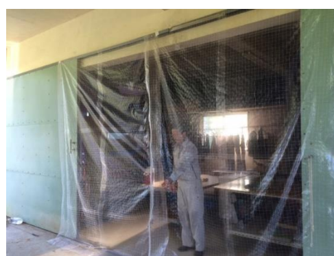
集荷場入口のネット設置
