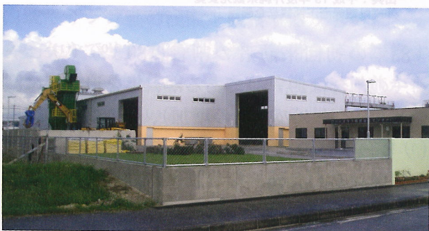
写真-3 バイオマス再資源化センター
