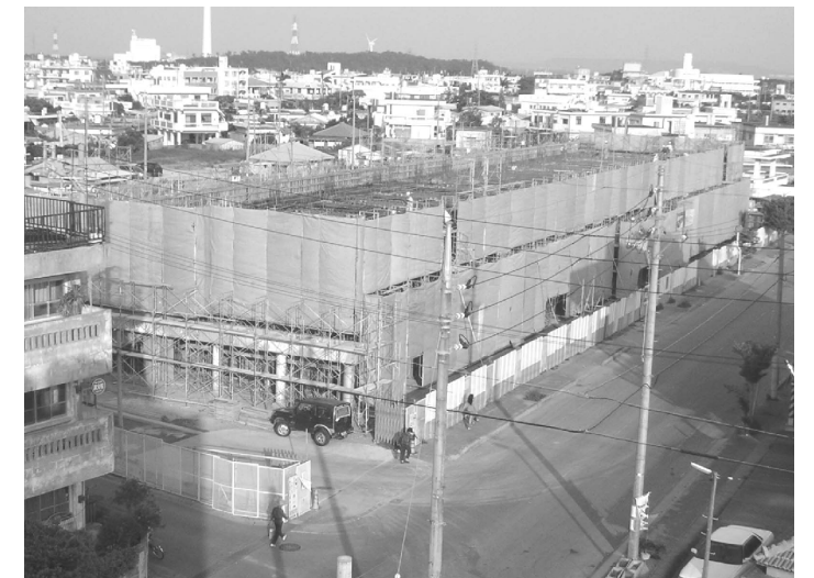
写真：改良住宅A棟建設現場の様子（10月16日撮影）
