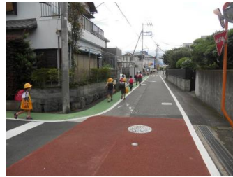
（カラー舗装の事例）
