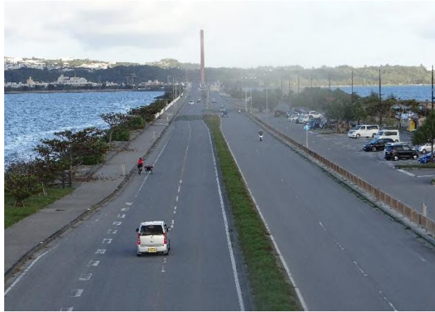
図1 海中道路の状況
