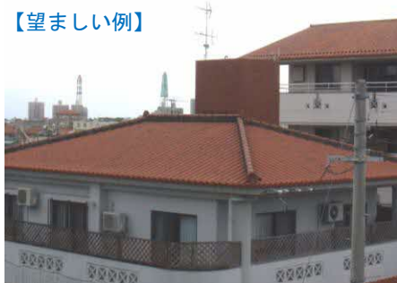
屋根と同じ素材による遮蔽
