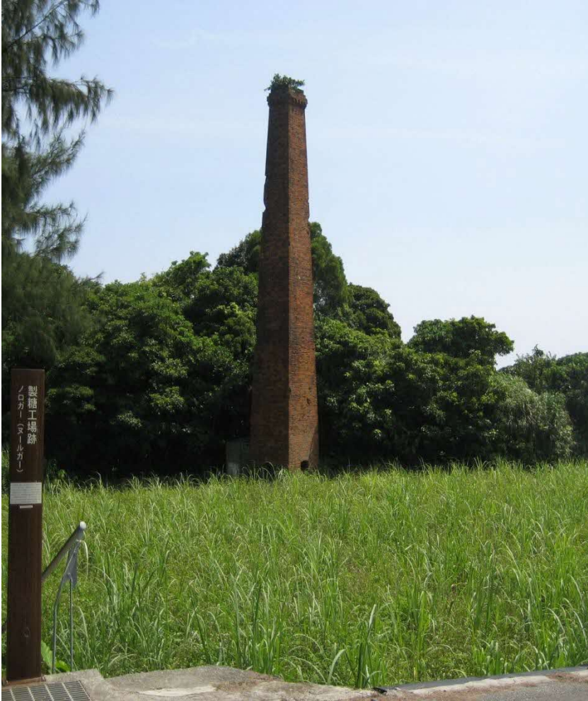
サーターヤーの煙突(勝連平敷屋)
