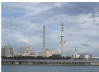
石川火力発電所(石川赤崎)
