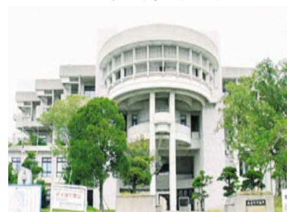
市役所本庁舎(みどり町)
