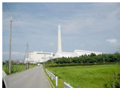
具志川火力発電所(字宇堅)
