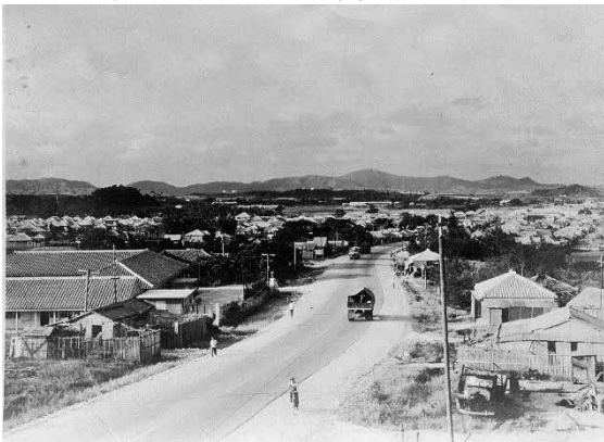
舗装されていないかつての道路
