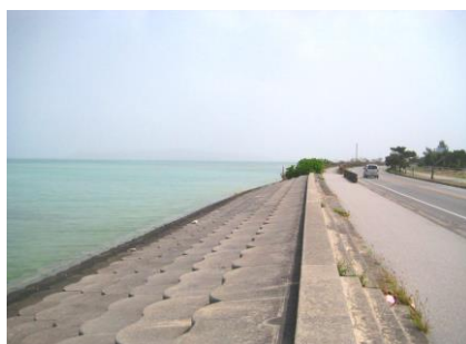
県道37号線(湾岸道路)からの眺望(与那城照間)
