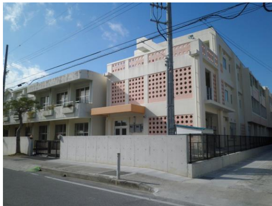
コンクリート造の建築物(勝連南風原)
