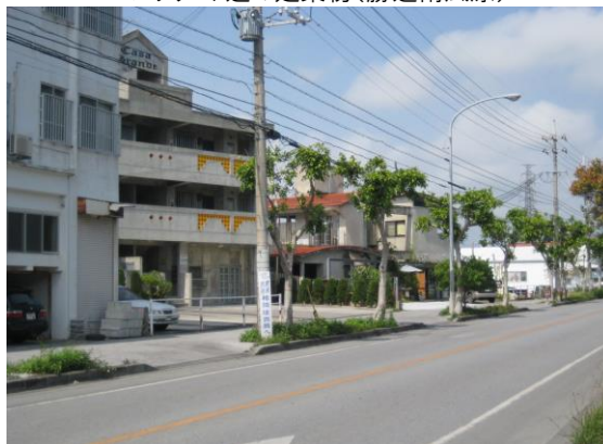
アスファルトで舗装され、電柱・街路灯が整備された現在の道路(宇具志川)
