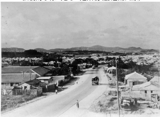
舗装されていないかつての道路
