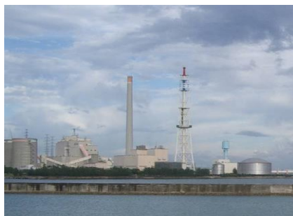
石川火力発電所(石川赤崎)
