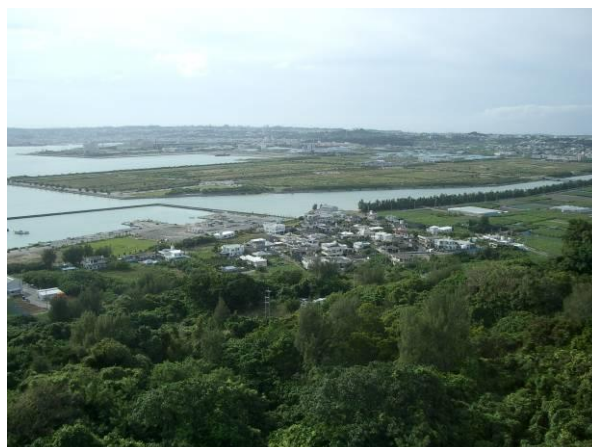
中城湾港新港地区工業団地(字州崎)
