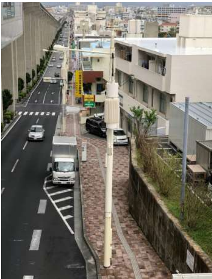
図5-4 ソフト地中化事例 県道82号線(那覇糸満線) (首里末吉町)
