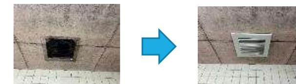
換気扇の改修
