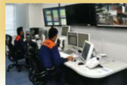
指令装置 具志川消防署に移設 (平成23年) 「指令制御装置Ⅱ型」
