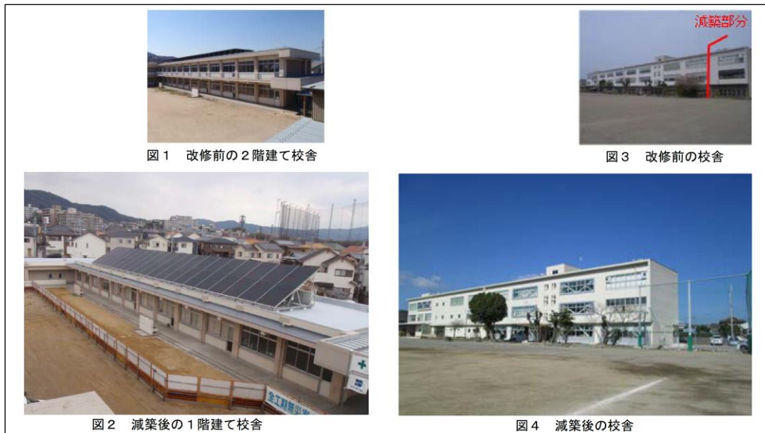
左：滋賀県大津市(2階部分の撤去による減築)、右：和歌山県有田市(使用頻度が低い棟の減築)
