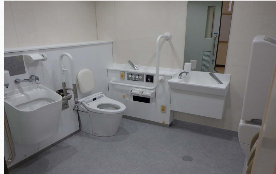
多目的トイレ
