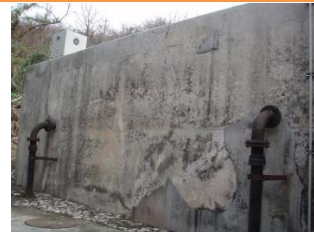
【与那城地区】 桃原配水池 建設年度 1975(昭和50)年度
