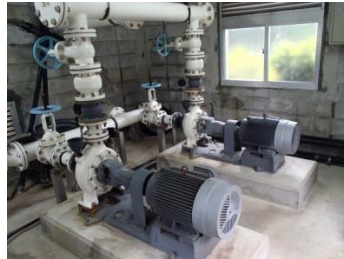
【勝連地区】 平安名ポンプ場
