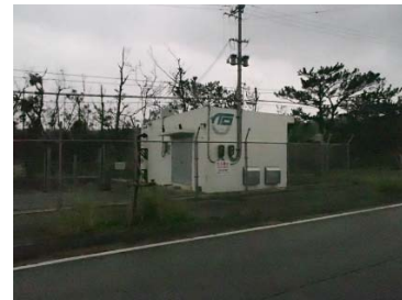
【石川地区】 高原ポンプ場 建設年度 1989(平成元)年度
