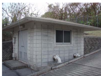
【勝連地区】 平敷屋ポンプ場 建設年度 1998(平成 10)年度
