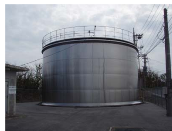
【与那城地区】 第2上原配水池 建設年度 1998(平成10)年度
