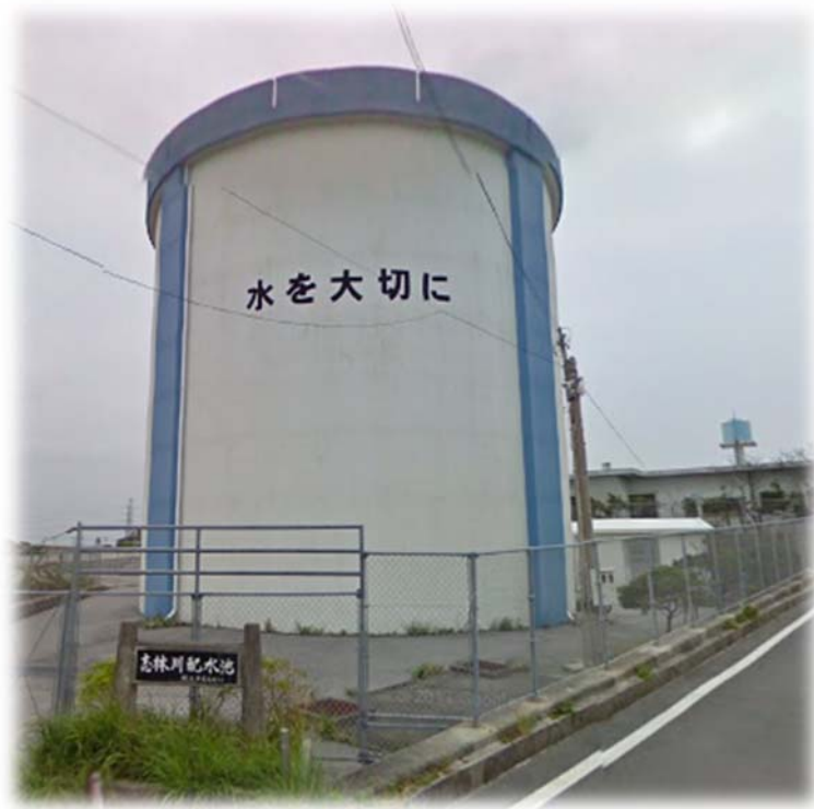
【具志川地区】志林川配水池
