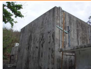
【与那城地区】 桃原配水池 建設年度 1985(昭和60)年度
