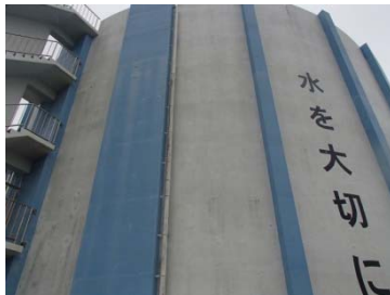
【具志川地区】 昆布配水池 建設年度 1989(平成元)年度
