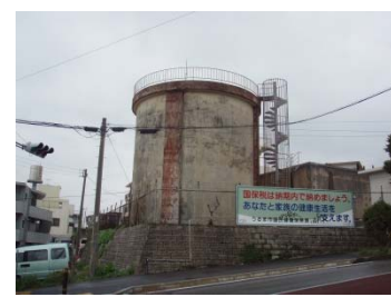
【石川地区】 第1配水池 建設年度 1978(昭和 53)年度
