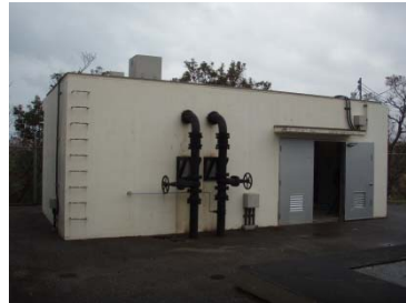
【石川地区】 警察学校前ポンプ場 建設年度 1991(平成 3)年度
