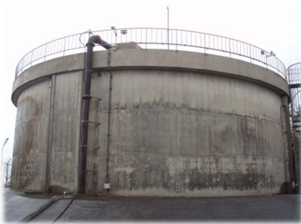
【石川地区】南配水池
