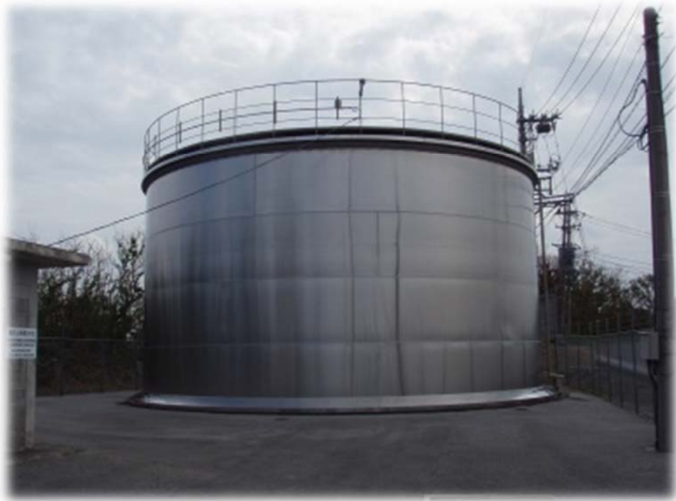
【与那城地区】第2上原配水池
