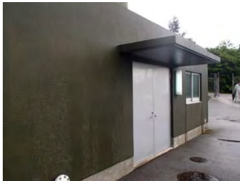
【勝連地区】 南風原ポンプ場 建設年度 2010(平成 22)年度
