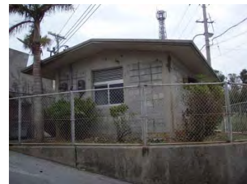
【勝連地区】 平安名ポンプ場 建設年度 1990(平成 2)年度
