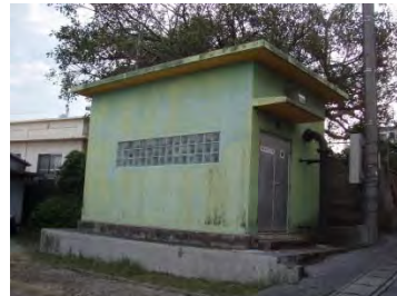
【与那城地区】 西原ポンプ場 建設年度 1985(昭和 60)年度
