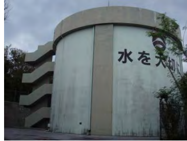
【勝連地区】 平敷屋配水池 建設年度 1997(平成9)年度
