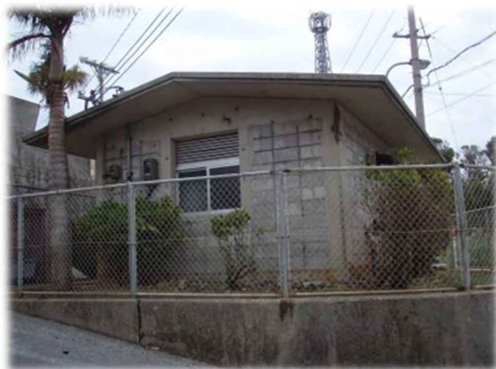
【勝連地区】平安名ポンプ場
