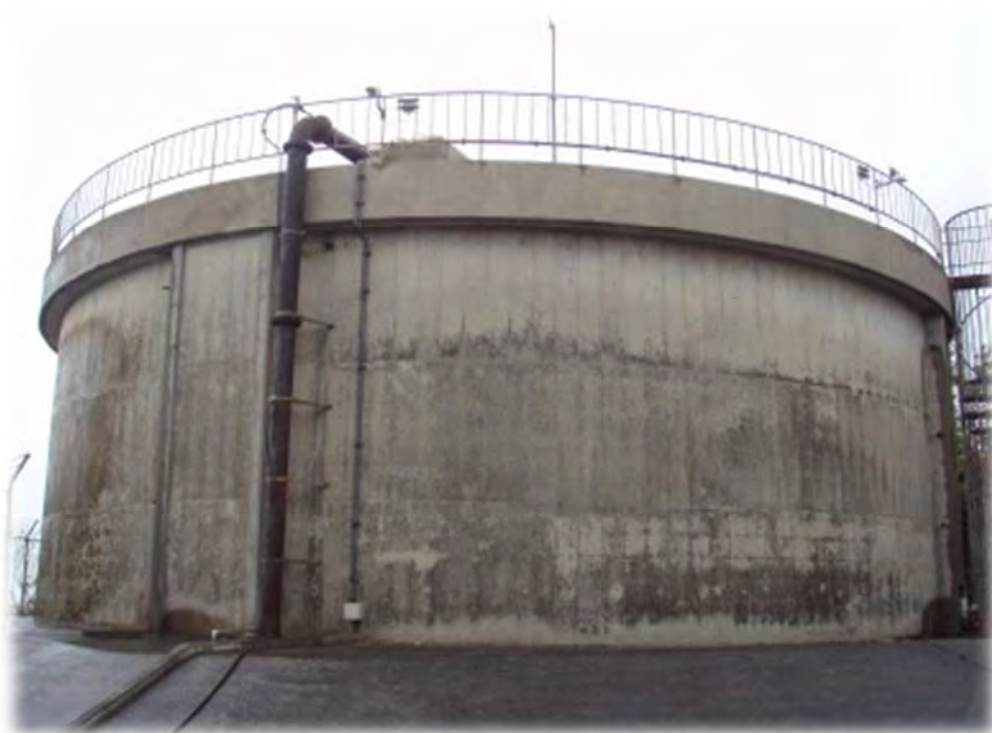
【石川地区】南配水池
