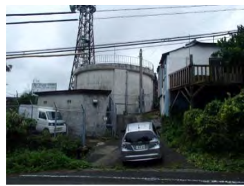
【石川地区】 高原配水池 建設年度 1984(昭和 59)年度
