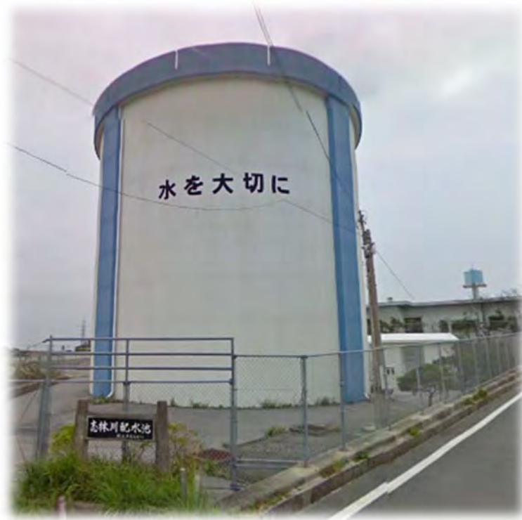
【具志川地区】志林川配水池
