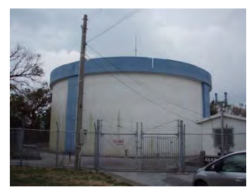
【具志川地区】 具志川配水池 建設年度 1987(昭和 62)年度
