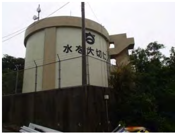
【勝連地区】 平安名配水池 建設年度 1994(平成6)年度
