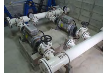
【勝連地区】 平敷屋ポンプ場
