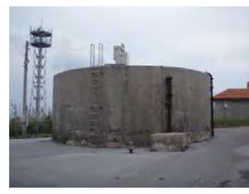
【勝連地区】 津堅配水池 建設年度 1988(昭和63)年度
