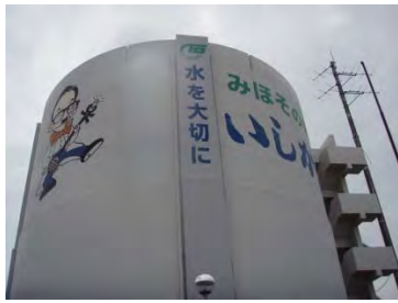
【石川地区】 東恩納配水池 建設年度 2002(平成 14)年度
