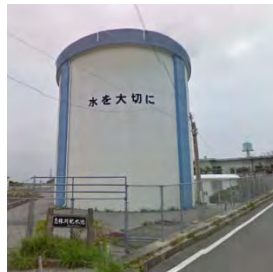
【具志川地区】 志林川配水池 建設年度 1988(昭和 63)年度
