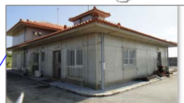
農業集落排水施設
