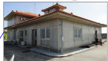
農業集落排水施設
