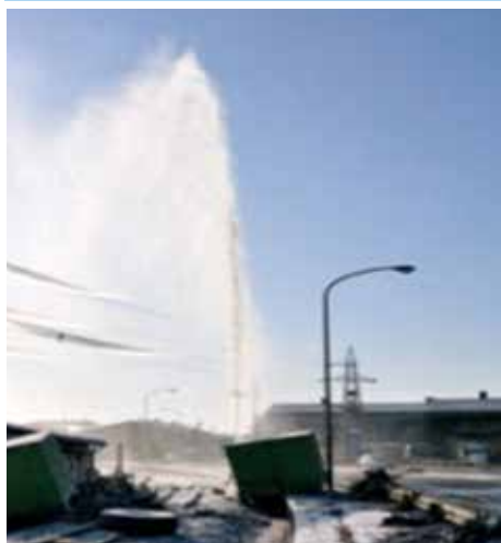
老朽管の漏水事故
