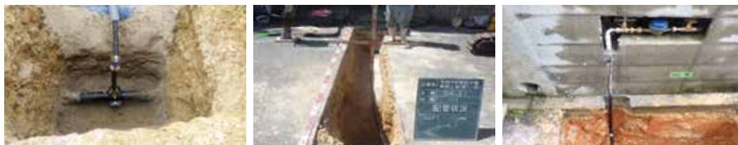
配水管からメーターまでの間を新しい管に取り替えます
