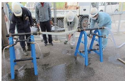
▲応急給水栓組み立ての様子
