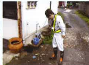
▲漏水調査作業状況(大浜由誠)
