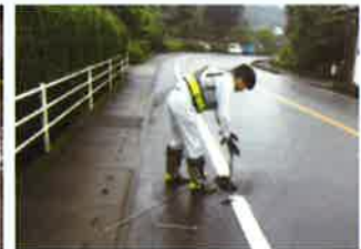
▲漏水調査作業状況(金城幸孝)
