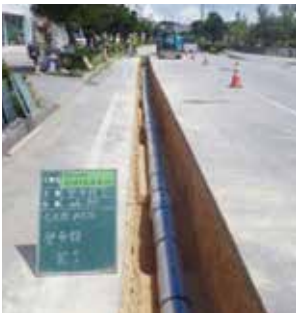
↑ 布設された耐震管
