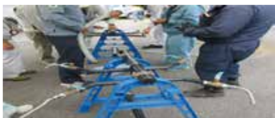
▲応急給水栓組み立ての様子
