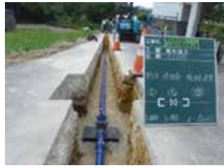
▲耐震管の布設
