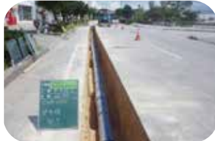
応急給水訓練の様子(与那城平安座) 更新した水道管(耐震管)
