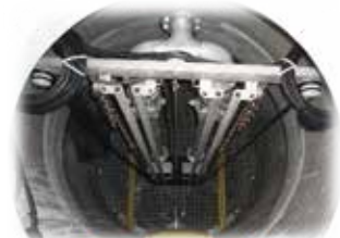
▲マンホールポンプ設置状況
