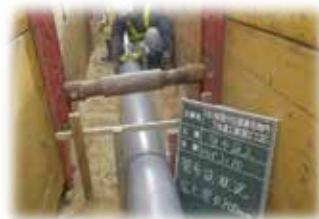
▲下水道管の設置工事
