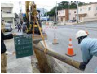
▲古くなった管の撤去
