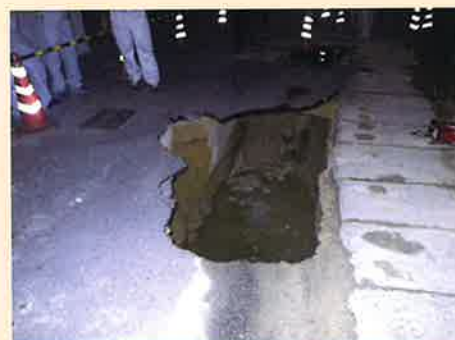
【下水道】宮里区内の本管陥没(2016年7月)
