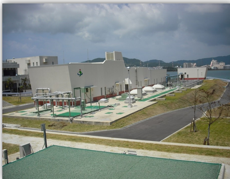
改築更新事業中の石川終末処理場
