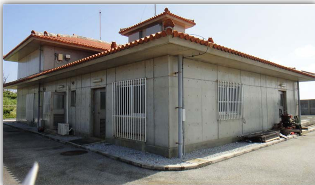
津堅地区污水处理施設
